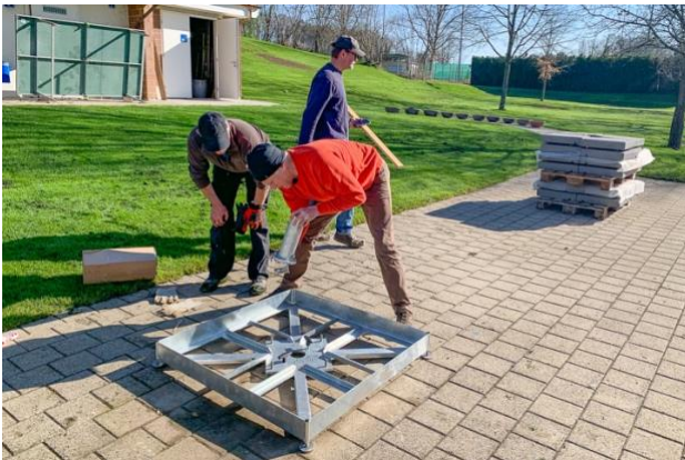
Der Bau der grossen Schirmsockel war knifflig.
